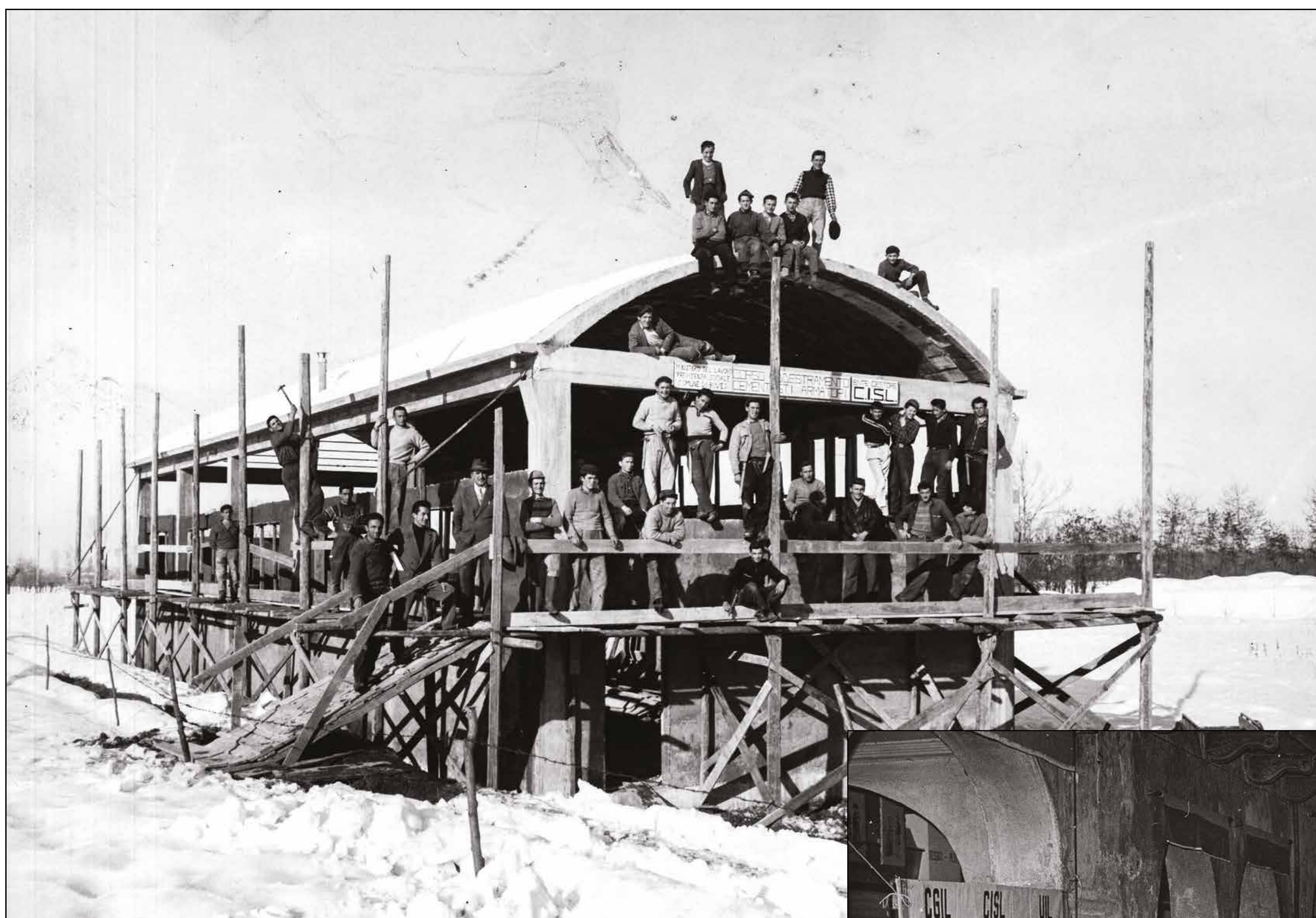
Fine anni Cinquanta. Corso di addestramento per cementisti ed armatori organizzato dalla Cisl di Cuneo a Boves.
